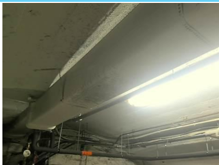
Matériaux : ZPSO-014 Prélèvement : 0 Description : Conduits Localisation : CENTRE BERTHELOT /BATIMENT H SOUS SOL - PIECE 3 Résultat : Présence d'amiante
