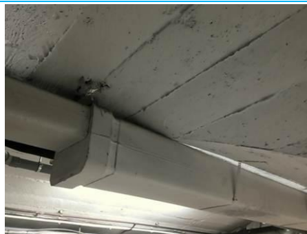
Matériaux : ZPSO-014 Prélèvement : 0 Description : Conduits Localisation : CENTRE BERTHELOT /BATIMENT H SOUS SOL - PIECE 3 Résultat : Présence d'amiante
